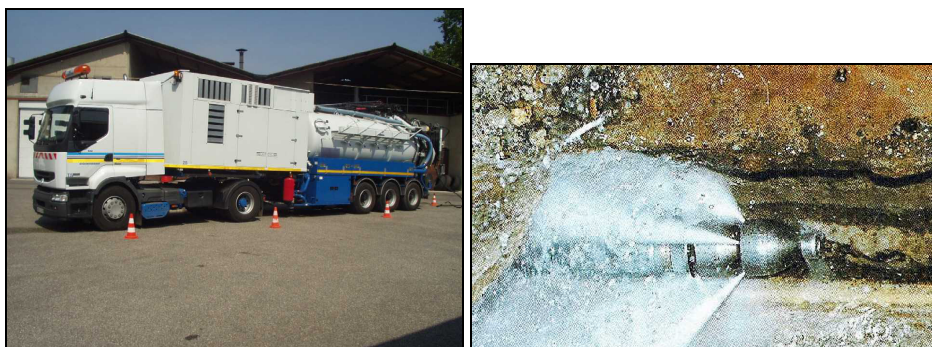
Photo 3a : camion de curage – Photo 3b : tête de curage (photos Grand Lyon – Direction de l'eau)
